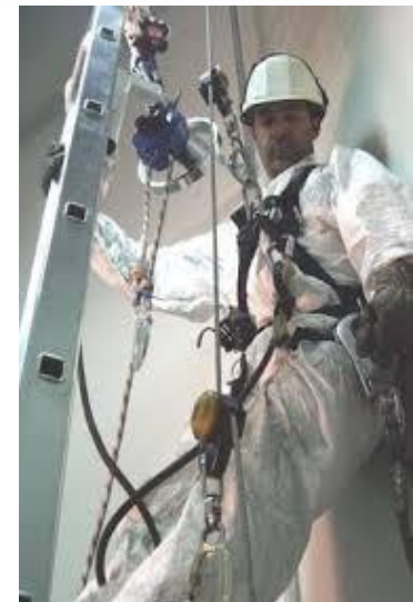
Figura 1. Operario equipado con arnés, absorbedor de energía con doble elemento de amarre, dispositivo anticaída deslizable para línea de anclaje rígida, casco de seguridad, botas de seguridad, linterna frontal para zonas de baja iluminación.
